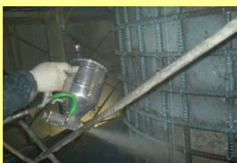
プライマー塗布
