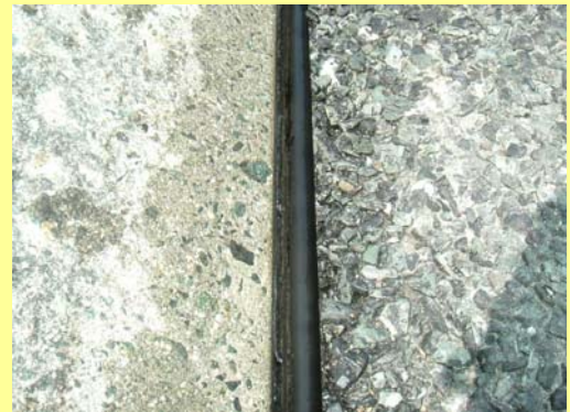
カッター溝施工後
