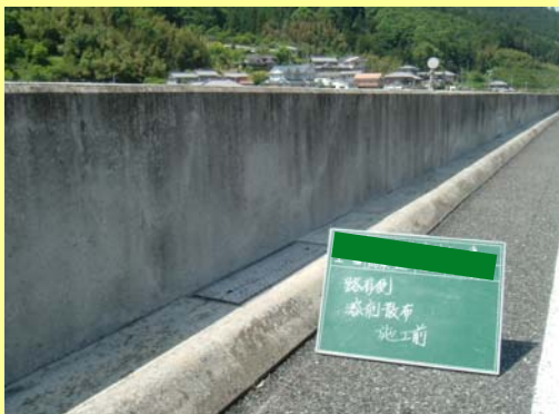
マウンタブル施工前
