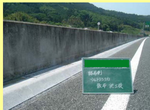
マウンタブル施工後
