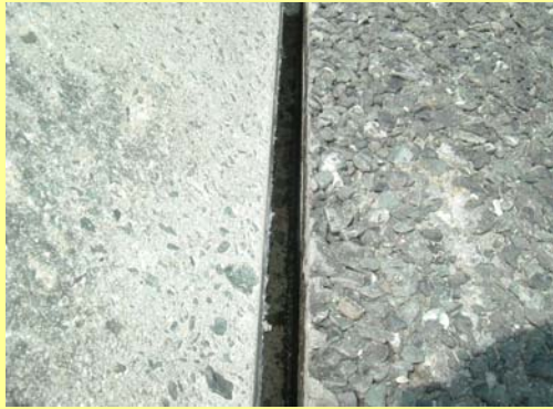
カッター溝施工前
