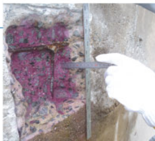
中性化深さ試験状況
