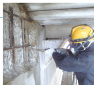
はつり調査状況
