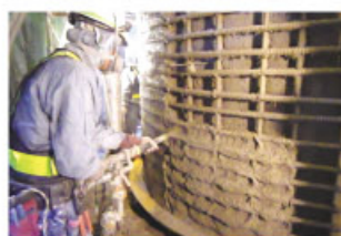
湿式吹付け状況 (SRS工法)
