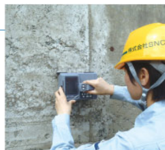
鉄筋探査状況
