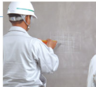
シュミットハンマーによる測定状況
