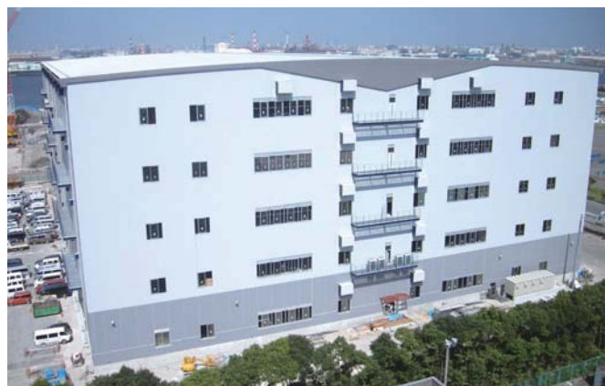
倉庫(外壁ワイドパネル)
