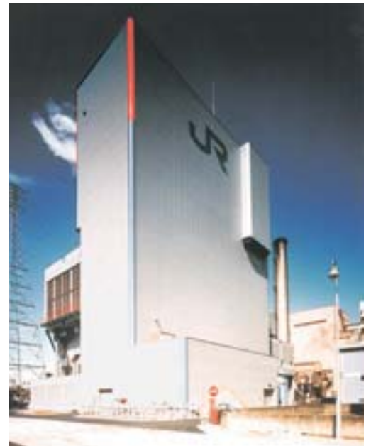
火力発電所(外壁)
