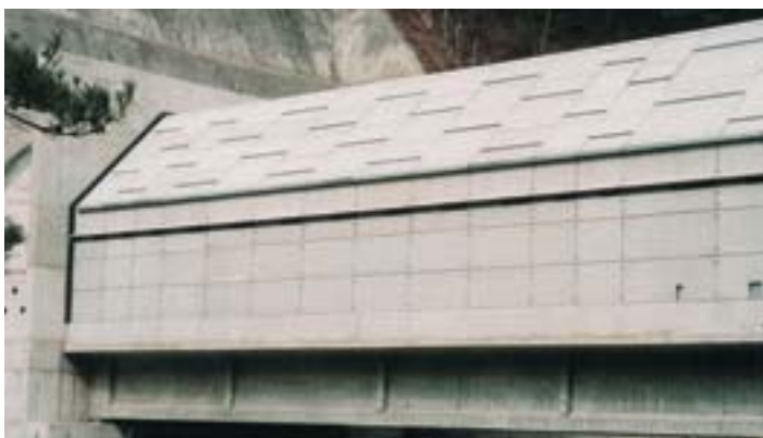
シェルター(外壁)
