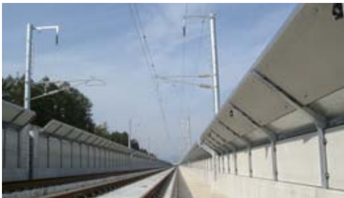
鉄道(防音壁 半雪覆タイプ)
