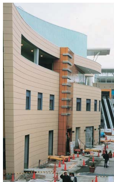
商業店舗ビル(化粧目地付外壁)
