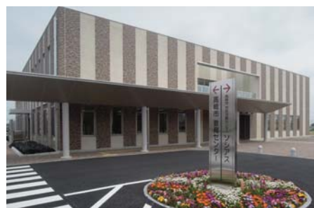
教育施設（タイル貼り）
