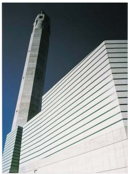
清掃工場(カラーセメント外壁)
