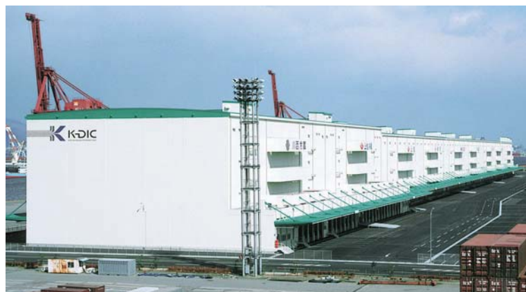
流通センター(床・外壁)
