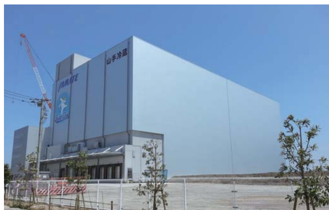
免震冷蔵庫(外壁)
