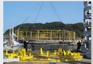
組立専用足場
