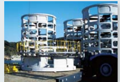
コンクリート部材組立
