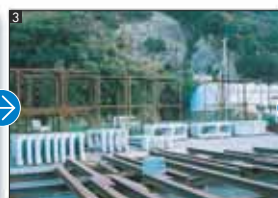
現場ヤードブロック仮置き
