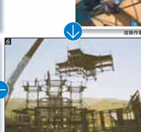
C部(通称:ブリッジ)架設状況
