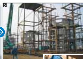
鋼製(Bブロック)組立状況
