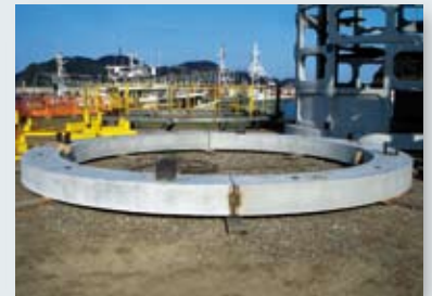
下端リング組立完了
