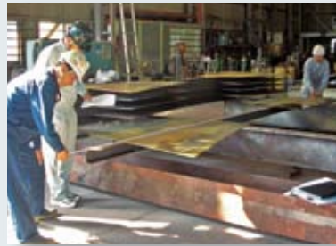
鋼製部材製作
