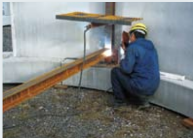
鋼製部材組立
