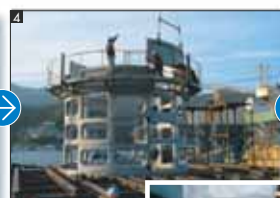
コンクリート部材組立
