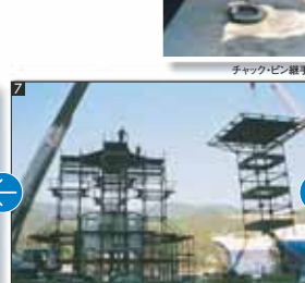
D部(通称:ヘリポート)架設状況
