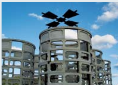
鋼製部材組立
