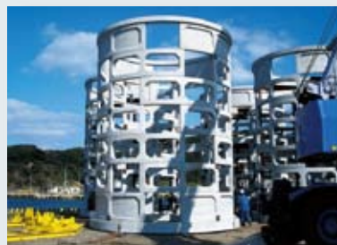
コンクリート部材組立完了
