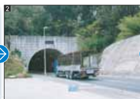
鋼製ブロック運搬
