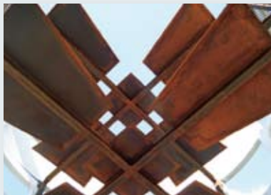
鋼製部材組立完了
