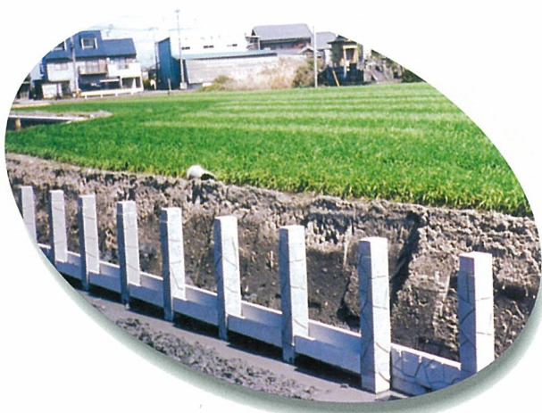
集落排水施設整備工事
