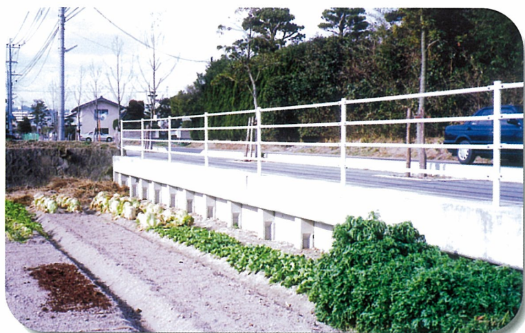
歩道設置 PCH 杭（普通地盤） 200 - 5m
