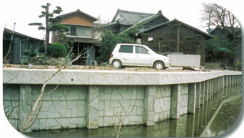
集落排水施設整備工事
