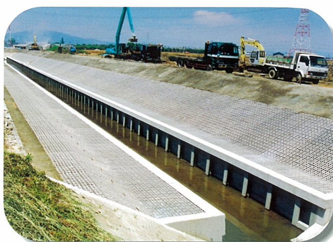
クリーク 防災機能保全水路工事
