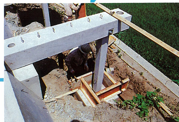
支柱・受梁組立
