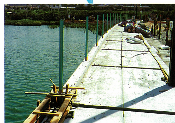
地覆・高欄工
