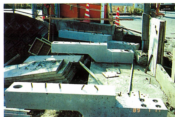
基礎工完了、部材搬入
